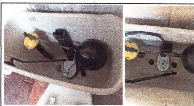
Foto 12: Sustrucción de accesorios para tanques de sanitarios lavables
