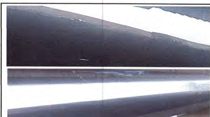
Foto 10: Sustrucción de canal de metal por canales de lámina aluzinc calibre 24 con sujetadores
