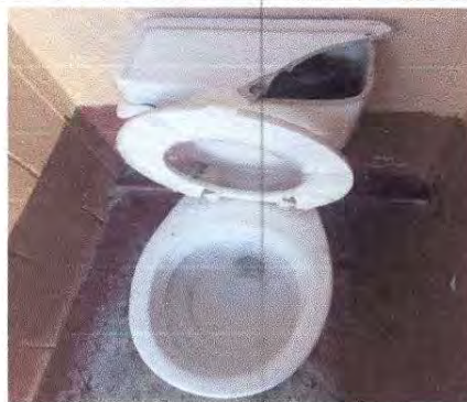
Foto14: Sustitución de un sanitario lavable
