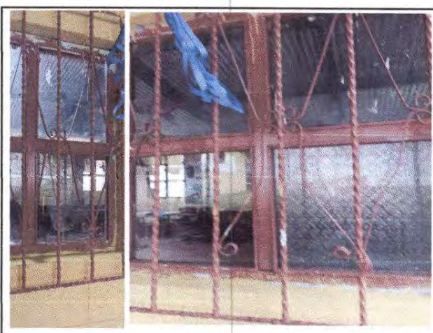
Foto 6: Sustrucción de ventanas de madera por ventanas de metal, más vidrio
