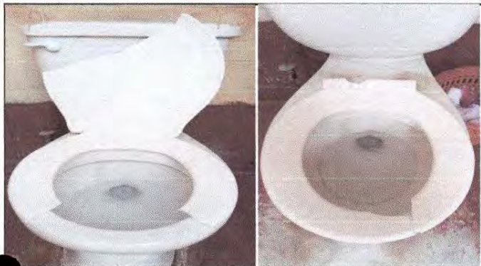
Foto 13: Sustitución de 5 tapaderas para sanitarios lavables
