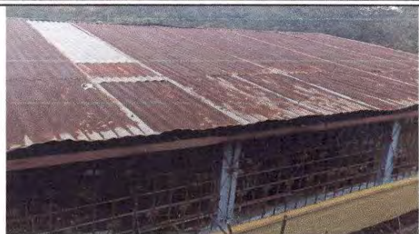
Foto 1: Sustrucción de lámina troquelada calibre 26 por lámina acanalada
