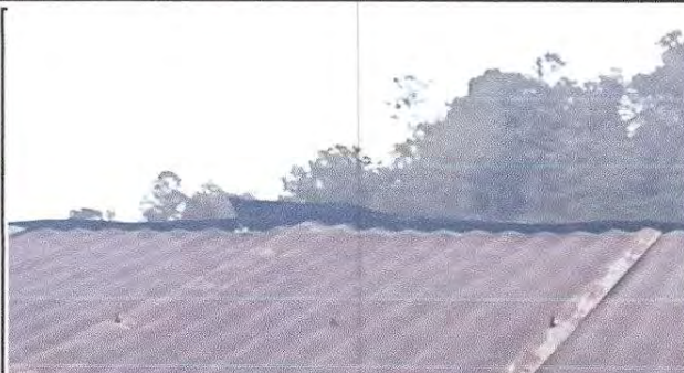
Foto 2: Sustrucción de capotes por capotes de lámina aluzinc
